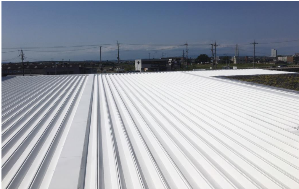
← 6月6日の状況 屋根面積（屋上緑化除く）の約100%塗装済
