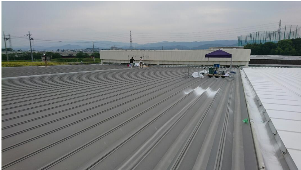
← 5月31日の状況 屋根面積（屋上緑化除く）の約40%塗装済
